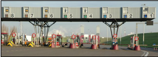
„Liefkenshoektunnel” díjszedőállomás Antwerpenben
